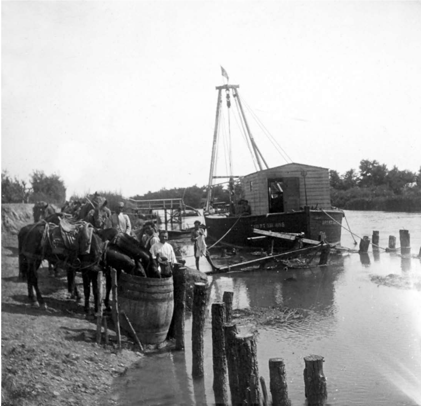
A Caposile stanno operando reparti di salmerie per il recupero dei materiali abbandonati.
